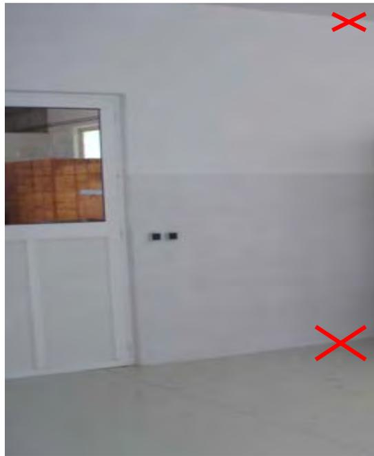
FIGURA 8 – Aspectos estruturais da unidade da produção primária de mel: as esquinas, ângulos e uniões entre paredes, entre paredes e pavimento e entre paredes e tecto devem ser arredondados (X assinala a ausência de perfil sanitário).
